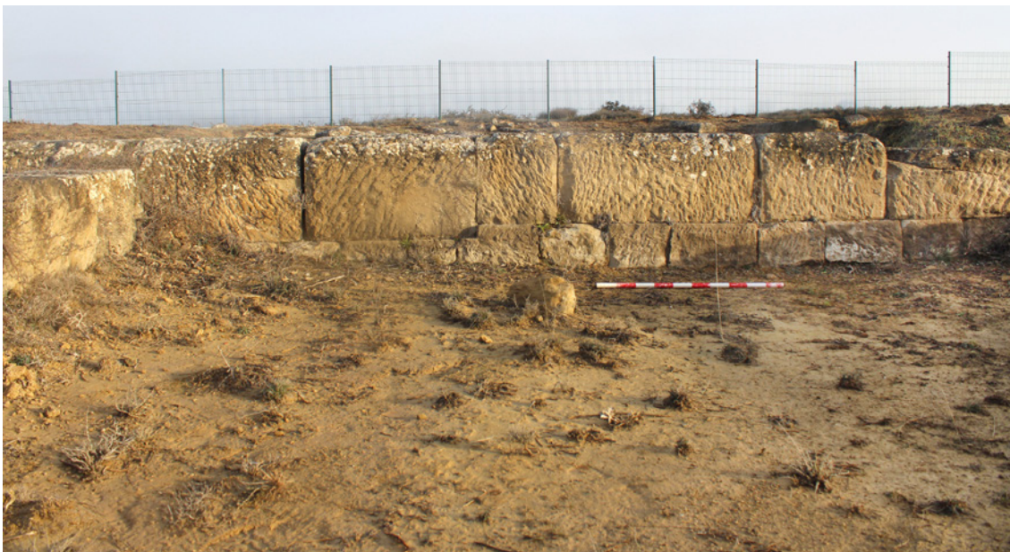
Fig. 3. Muro perimetral Norte de la estancia 4.
