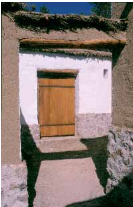
Reconstrucció de una vivenda d'època ibèrica en la Bastida de les Alcusses a partir de tècniques constructives tradicionals. Any 1999.
