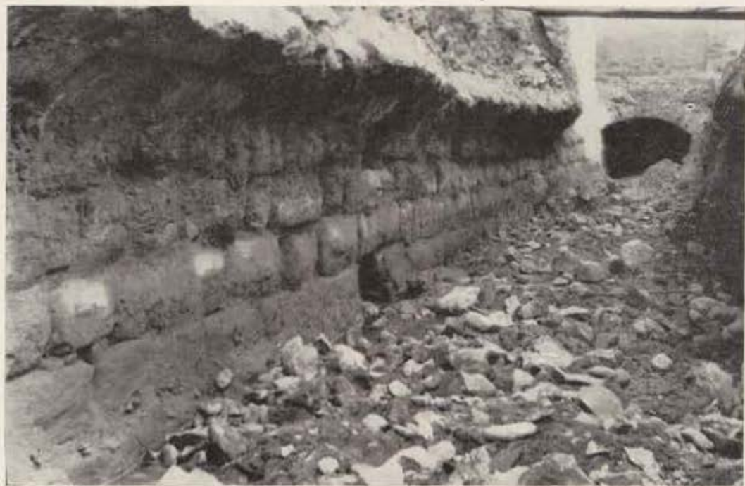
a) Conjunto del muro meridional puesto al descubierto en 1962.
